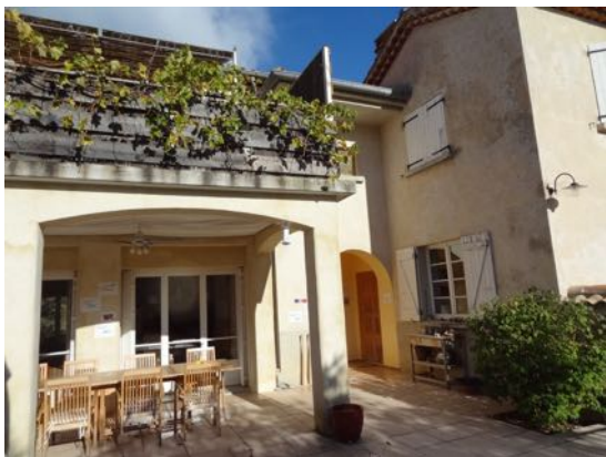
La Roseraie, entre les collines provençales
