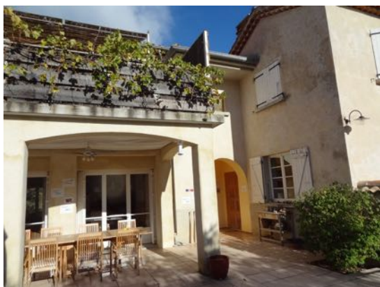
La Roseraie, entre les collines provençales
